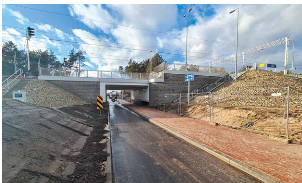
Poza przedłużeniem Komunalnej i Mościckiego oraz remontowi wiaduktu kolejowego, w ramach inwestycji powstał również nowy odcinek ul. Majdan oraz ostatni fragment ścieżki rowerowej łączącej centralną część miasta z przemysłową
