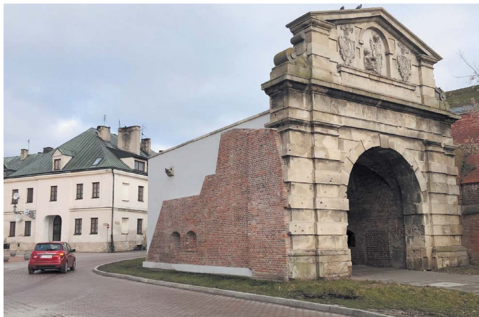
Stara Brama Lwowska jest jednym z najcenniejszych zabytków Zamościa. Została odnowiona częściowo w zeszłym roku dzięki 190 tys. zł, jakie pozyskano z ministerialnego programu „Ochrona zabytków 2022”
