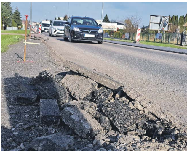
Asfalt został zdarty m.in. na odcinku kilkudziesięciu metrów jednego pasa ruchu w pobliżu skrzyżowania w Kalinowicach
