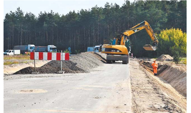
Kielecka firma Trakt buduje brakujący fragment drogi łączącej Borową k. Dęblina z położonym kilkaset metrów za wioską przystankiem kolejowym
