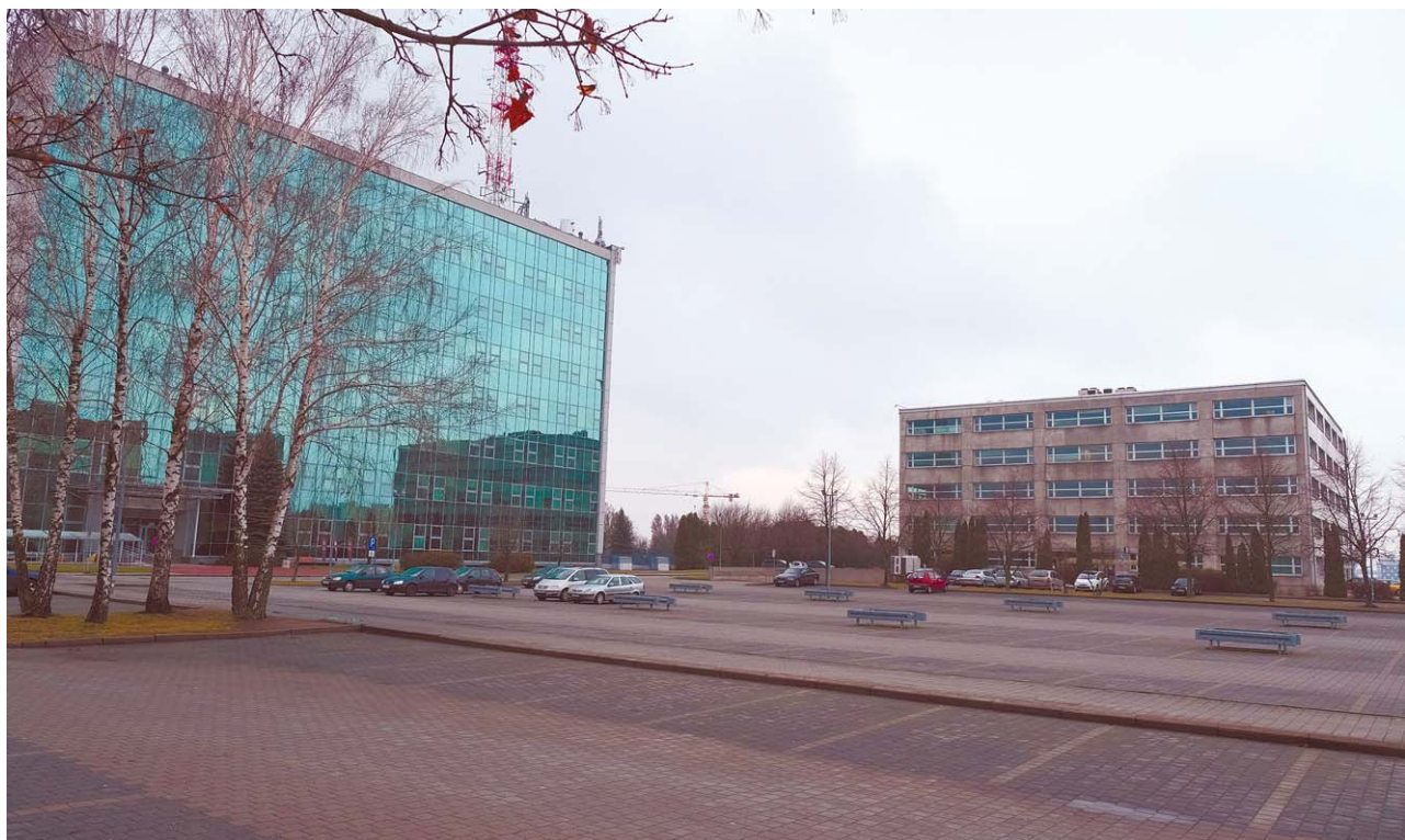
Budynek po lewej stronie nie był przedmiotem transakcji. Deweloper kupił od Orange widoczny w głębi zdjęcia biurowiec, a także widoczny na pierwszym planie teren, na którym ma prawo postawić nowe budynki z lokalami usługowymi i mieszkalnymi. Za grunt oraz biurowiec spółka Orange Polska życzyła sobie 25,6 mln zł, a przynajmniej taką cenę podawała w oficjalnym ogłoszeniu
