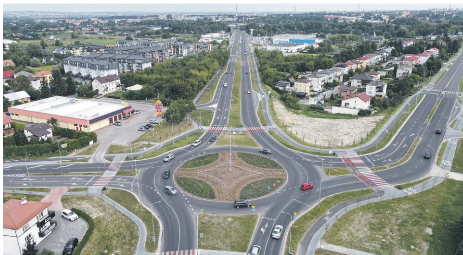
Rondo ul. Dzieci Zamojszczyzny, ul. Szczepczeska, ul. Śląska
