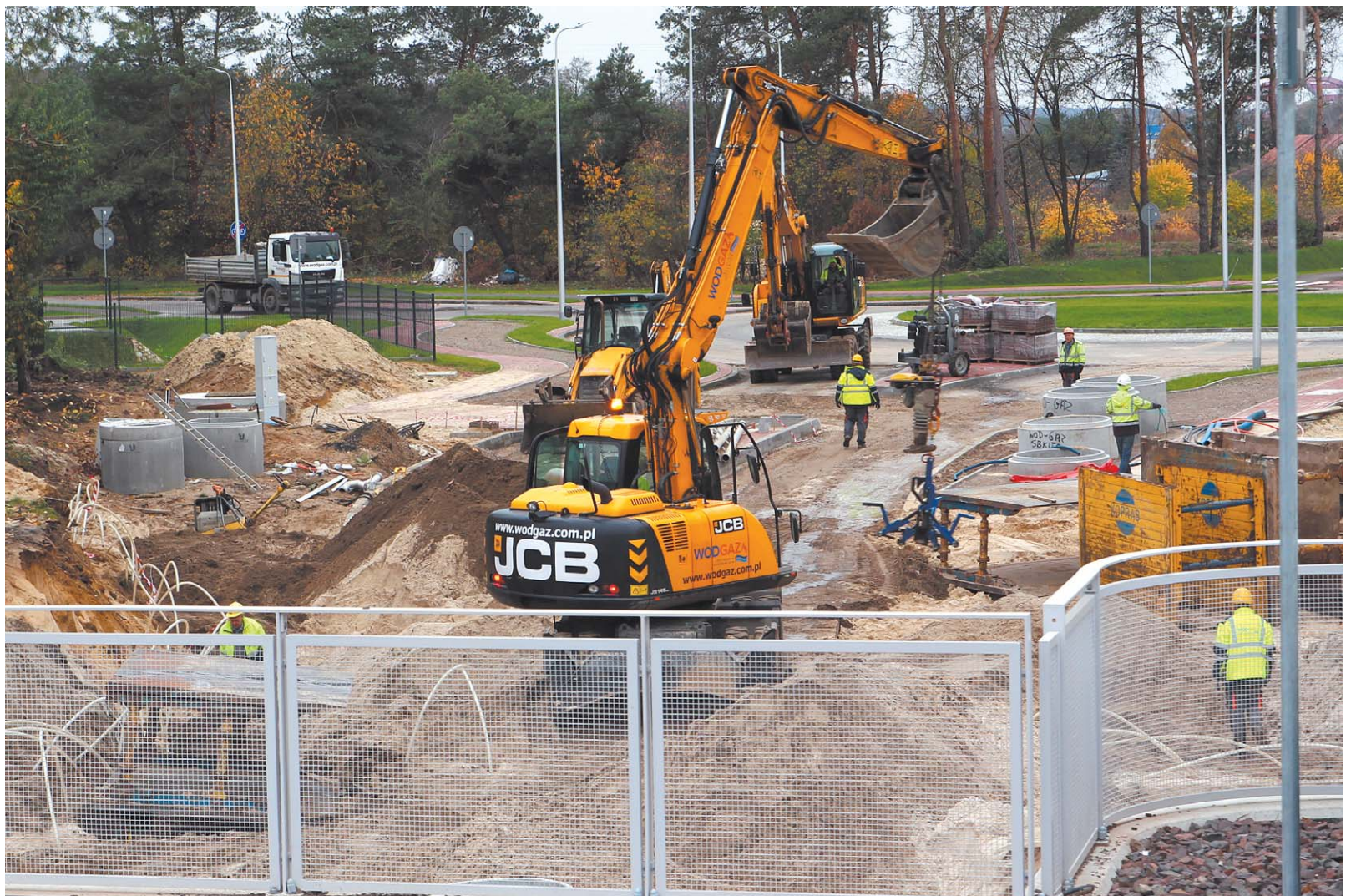
Przebudowa ul. Mościckiego to część dużej inwestycji na osiedlu Majdan. Jej wartość przetargowa to prawie 3,9 mln zł, ale ta najpewniej zostanie przekroczona
