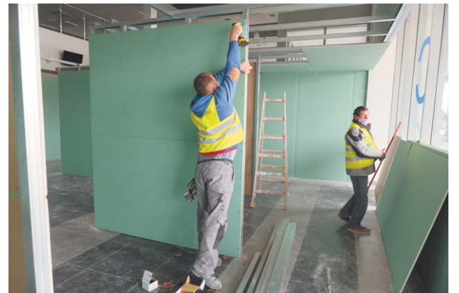
Wykładana jest podłoga, montowane są ścianki działowe
