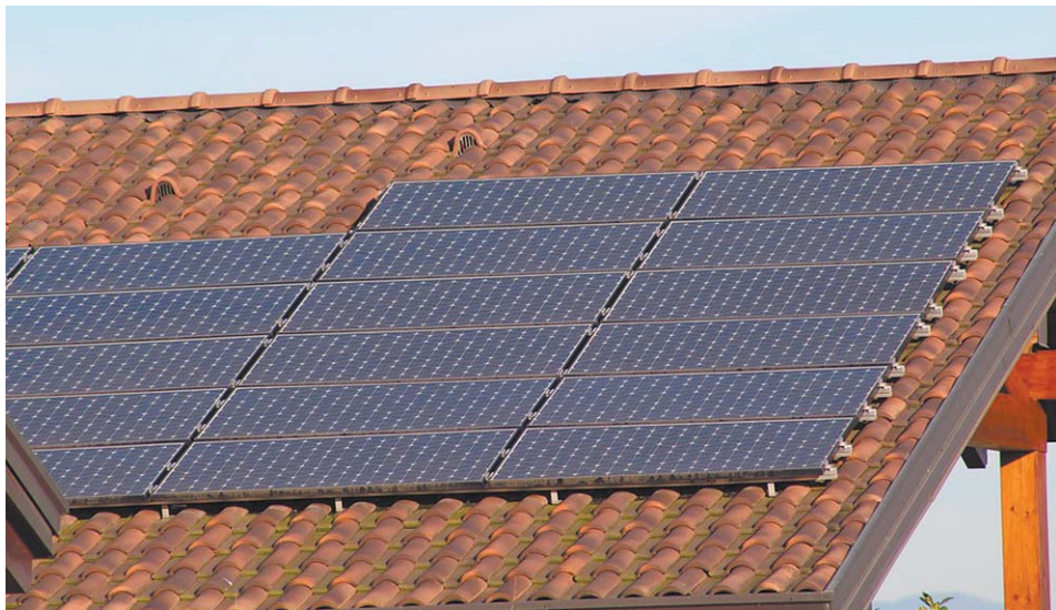
Mieszkańcy, którzy wezmą udział w projekcie, wyłożą z własnej kieszeni od 3 do 10 tys. zł. Te kwoty zależą od miejsca montażu i mocy instalacji
