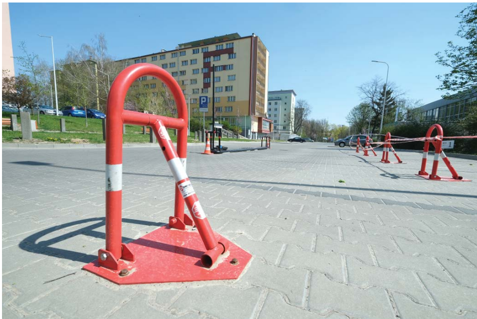
Na parkingu przed Centrum Kultury Fizycznej trwa montaż systemu płatnego parkowania.
