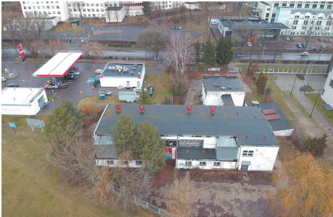
Teren dawnej podstacji ciepłej przy Głębokiej od kilku lat jest własnością prywatnej firmy, która przymierza się tutaj do inwestycji
