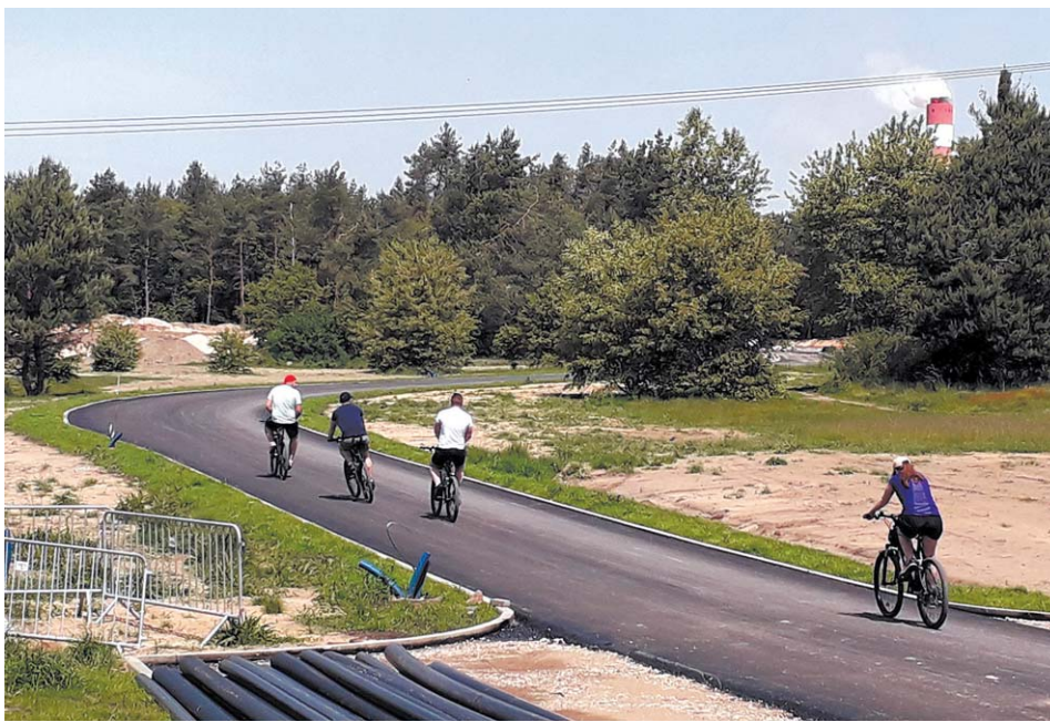
Wokół Puław przybywa nowych ulic i ścieżek rowerowych. Za niecałe dwa miesiące gotowy ma być odcinek od przejazdu pod S12 do ul. Mościckiego
