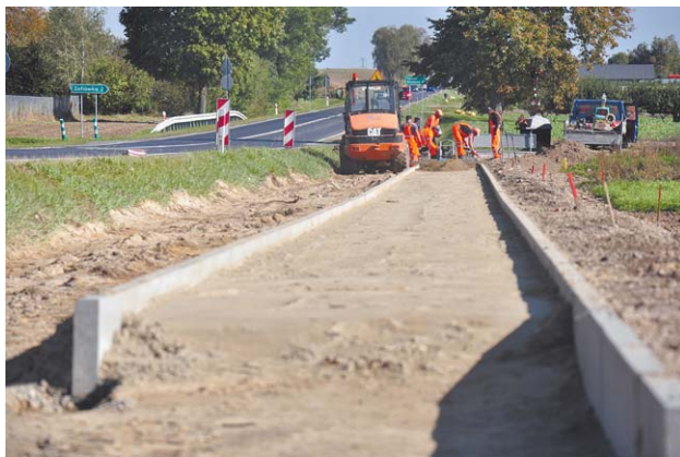
Drogowcy przebudują też skrzyżowanie w Łuszczowie z drogą powiatową 2000L.
