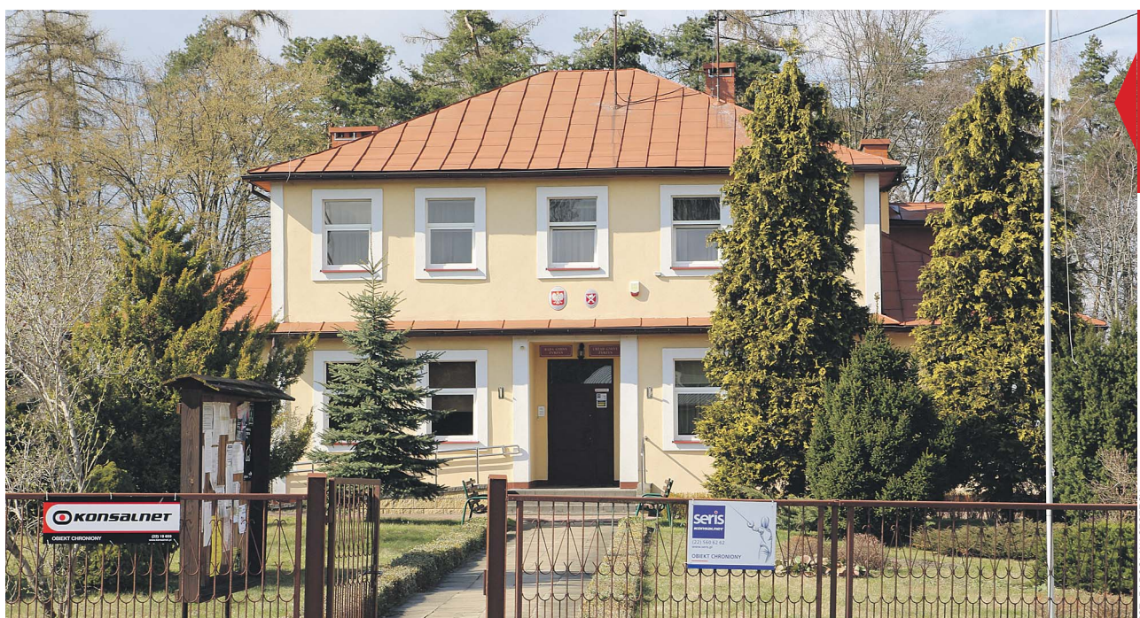
Nowy gmach ma powstać na tyłach starego budynku, który po przeprowadzce urzędników, będzie mógł zostać rozebrany. Na jego miejscu w przyszłości powstanie parking
