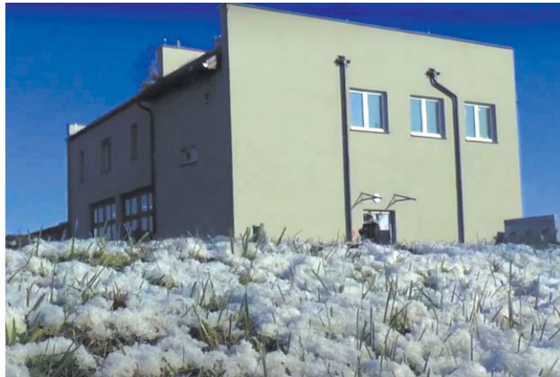
Gmina wyremontowała już jeden budynek na potrzeby spółdzielni
