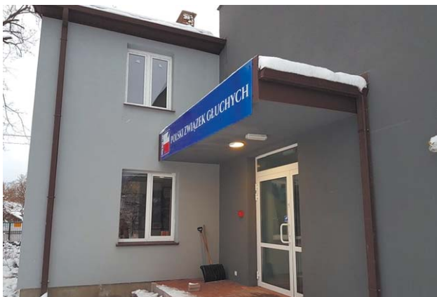
Nowa siedziba jest już gotowa i częściowo użytkowana
