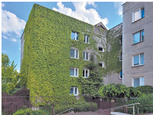
Ściana bloku na ul. Nowowiejskiego
