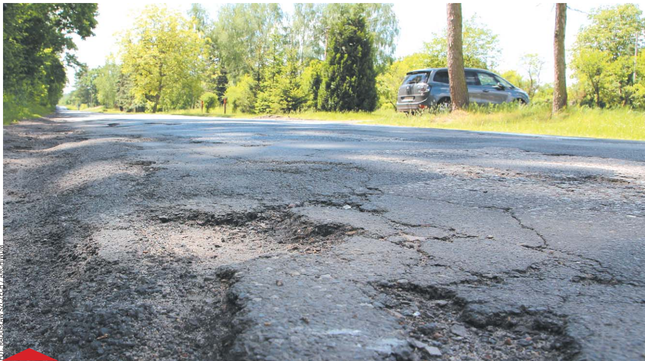
Trasa z Góry Puławskiej do Janowca będzie remontowana w dwóch etapach. Do połowy przyszłego roku gotowy ma być jej powiatowy odcinek (na zdjęciu). Na zajęcie się fragmentem wojewódzkim zaczekamy do roku 2025
