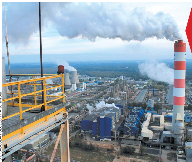
Polska zużywa ok. 20 miliardów metrów sześciennych gazu rocznie, z czego 1 mld to zapotrzebowanie Zakładów Azotowych w Puławach. Gaz jest podstawowym surowcem do produkcji nawozów
