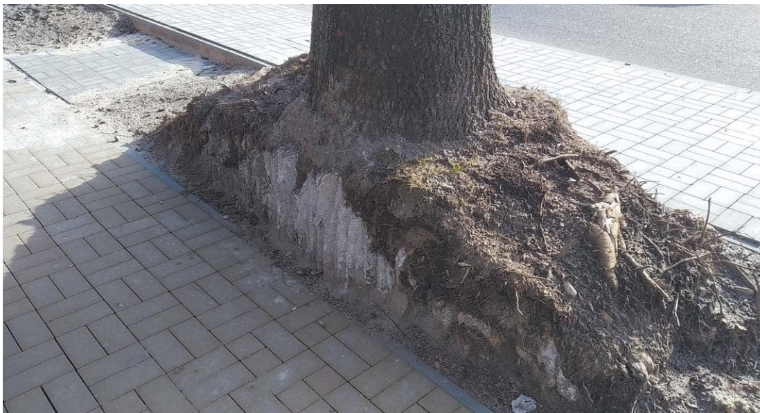
Do kategorii drzew silnie uszkodzonych dendrolog zakwalifikował 9 szt. drzew, w tym dwa „jako silnie uszkodzone z zagrożoną stabilnością”
