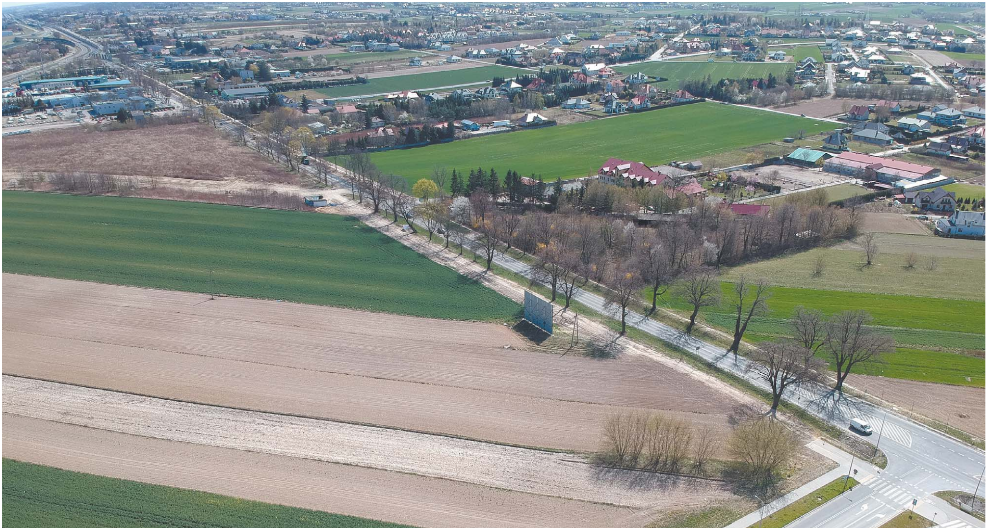
Blokki wysokie na osiem pięter planiści widzą w miejscu otoczonym al. Witosa, ul. Zygmunta Starego, Królowej Jadwigi i Zygmunta Augusta
