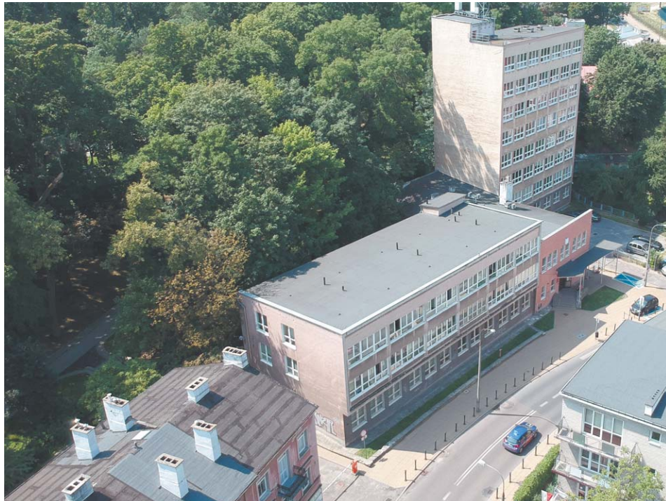
Leszczyńskiego 20. Aktualna siedziba urzędników. Do wyburzenia
