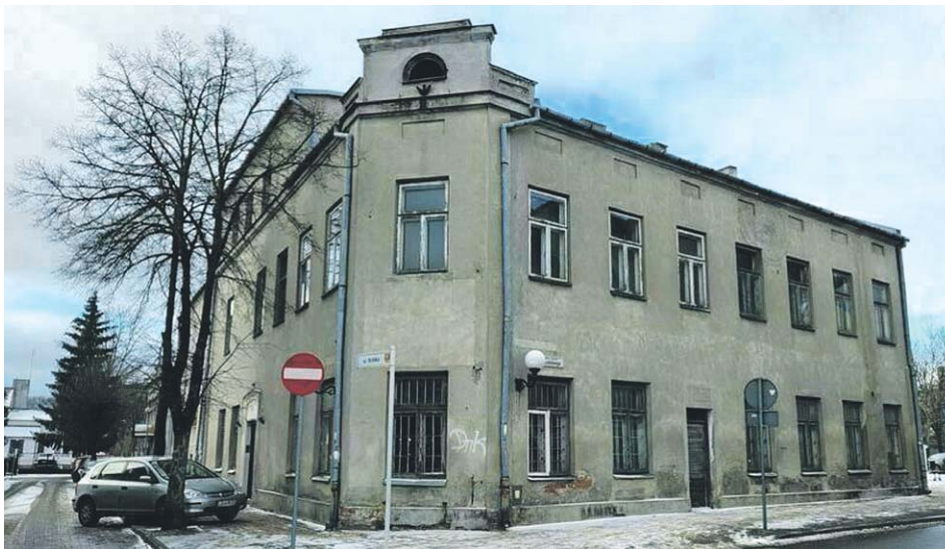
W miejscu tej kamienicy ma powstać nowy obiekt
