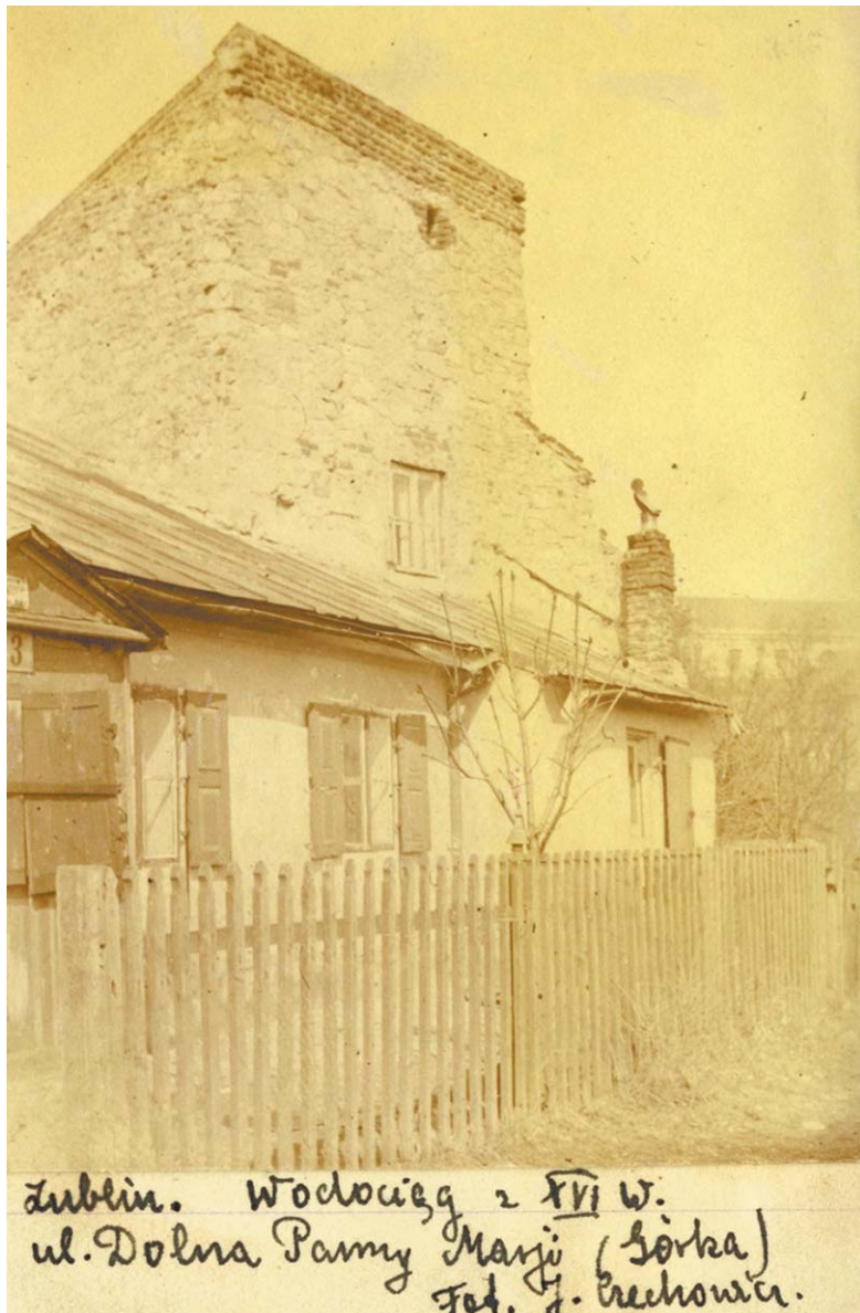
Wieża wodna przy ulicy Dolnej Panny Marii
