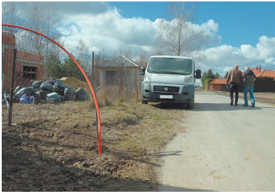
Wykonawcy stanęli ze światłowodem przy posesji mojego sąsiada – mówi nasz czytelnik
