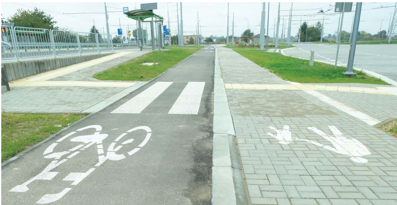
Pętla powstała przy okazji przebudowy 900-metrowego odcinka ul. Choiny od skrzyżowania z ul. Wojtasa do północnej granicy miasta. Prace kosztowały ponad 37 mln zł.
