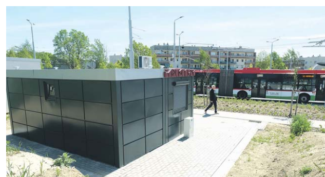
Podczas budowy i przebudowy pętli komunikacji miejskiej ustawiono sześć takich budynków z toaletami
