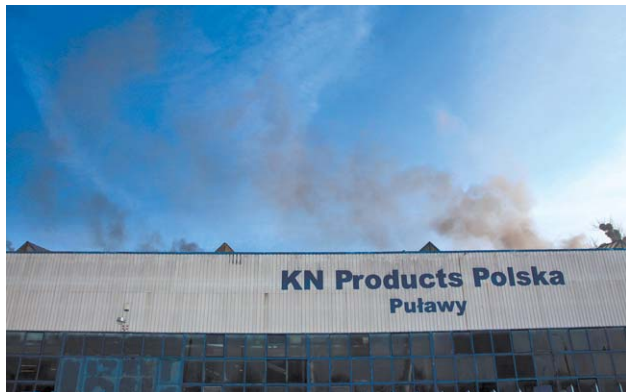
Mieszkańcy od lat sygnalizują problem dotyczący dymu, który wydobywa się z kominów firmy KN Consult. Jedyne, co się udało, to przekonanie właściciela spółki do zakupu węgla o niższym stopniu zanieczyszczenia
