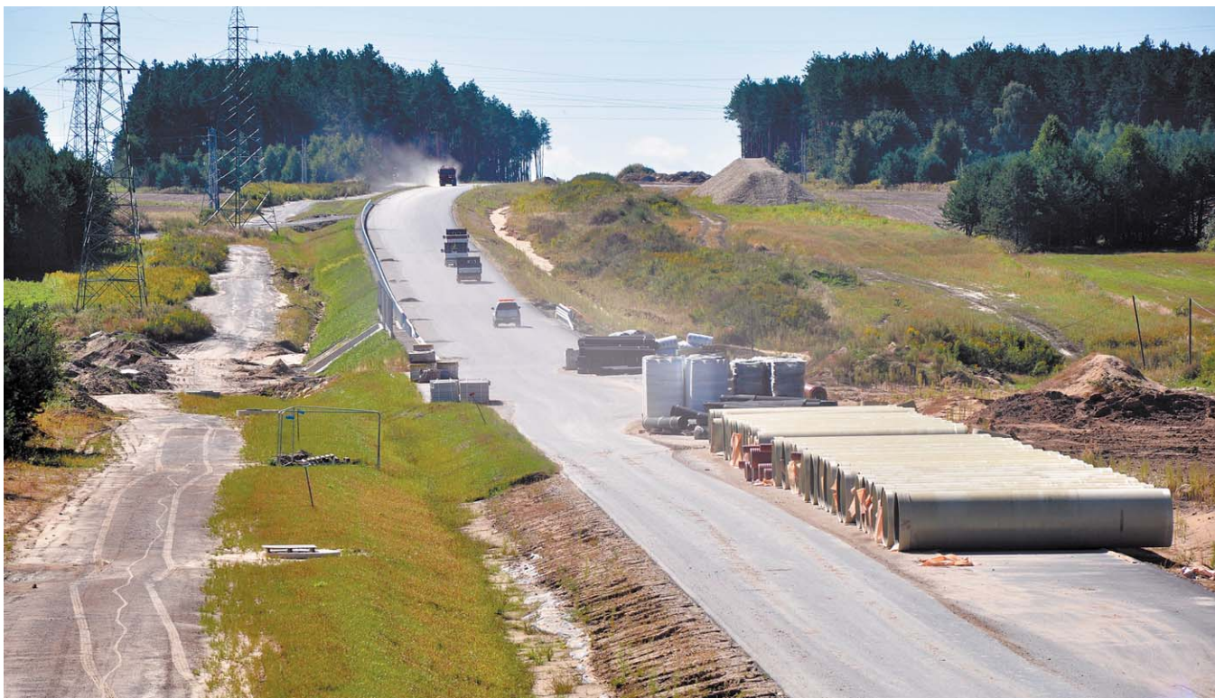
Trwa układanie nawierzchni i budowa mostów na obwodnicy Tomaszowa Lubelskiego
