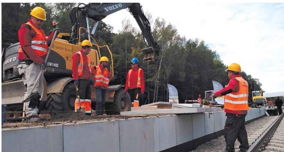
Nowy przystanek Lublin-Zachód. Na razie gotowa będzie tylko jedna krawędź peronu, podziemne przejście i winda dla niepełnosprawnych
