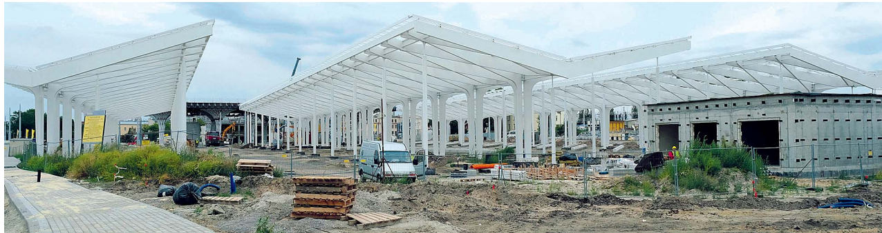
Obecnie obowiązującą datą zakończenia budowy dworca jest 28 lutego 2023 roku
