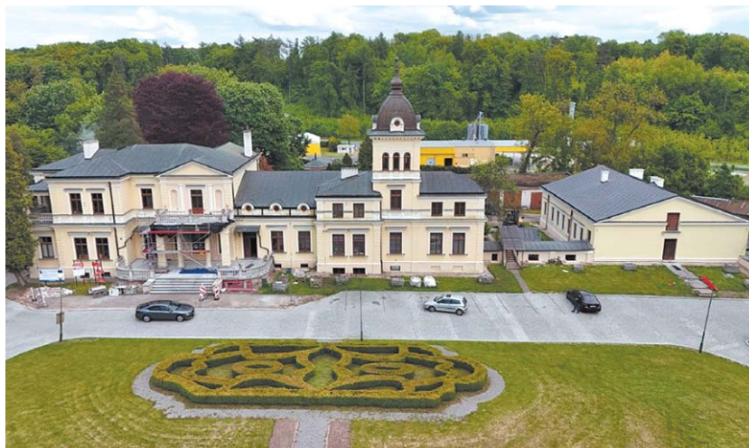
Pałac w trakcie prowadzonych prac
