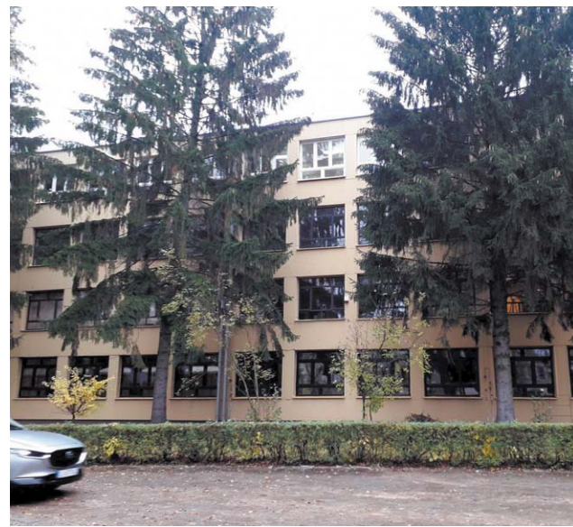
W budynku Zespołu Szkół Transportowo-Komunikacyjnych wymieniono już pierwsze okna
