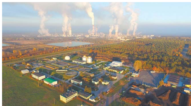
12 650 metrów sześciennych na dobę - to przepustowość puławskiej oczyszczalni ścieków. Zakład zlokalizowany w północnej części miasta w ostatnim tygodniu oglądali zainteresowani ekologią goście z Białorusi
