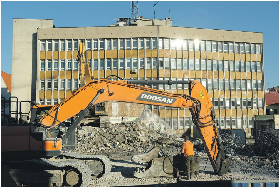
Od wymontowywania okien rozpoczęło się wyburzanie przy ul. Karmelickiej
