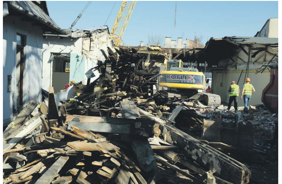
Prace u zbiegu ul. Jasnej i Wieniawskiej. Robią miejsce pod 325 mieszkań
