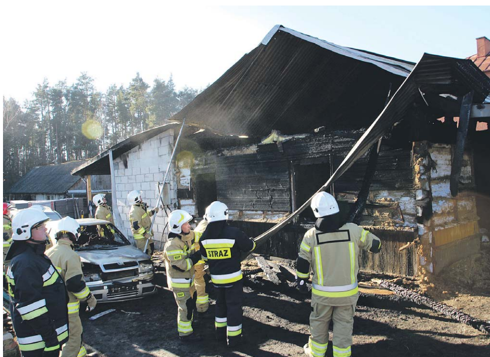
Na zdjęciu strażacy, którzy w piątek prowadzili prace rozbiórkowe
