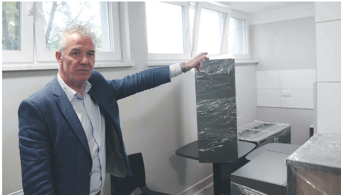
W jednym z domów studenta Politechniki Lubelskiej trwa wakacyjny remont. Postęp prac sprawdza Miroslaw Żuber, kanclerz uczelni
