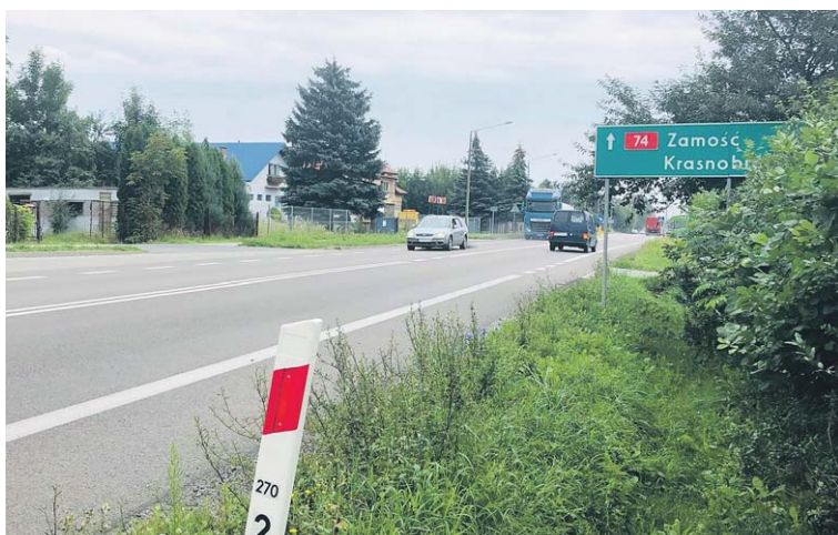
Krajowa 74 miała być przebudowywana na kilkunastokilometrowym odcinku od Zamościa do Klemensowa. Ale GDDKiA jednak się z tej inwestycji zupełnie wycofała
