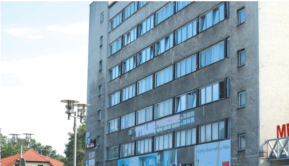
Budynek jest podłączony do sieci ciepłowniczej i gazowej. Nie ma zatem mowy o butlach, czy innych prowizorycznych rozwiązaniach
