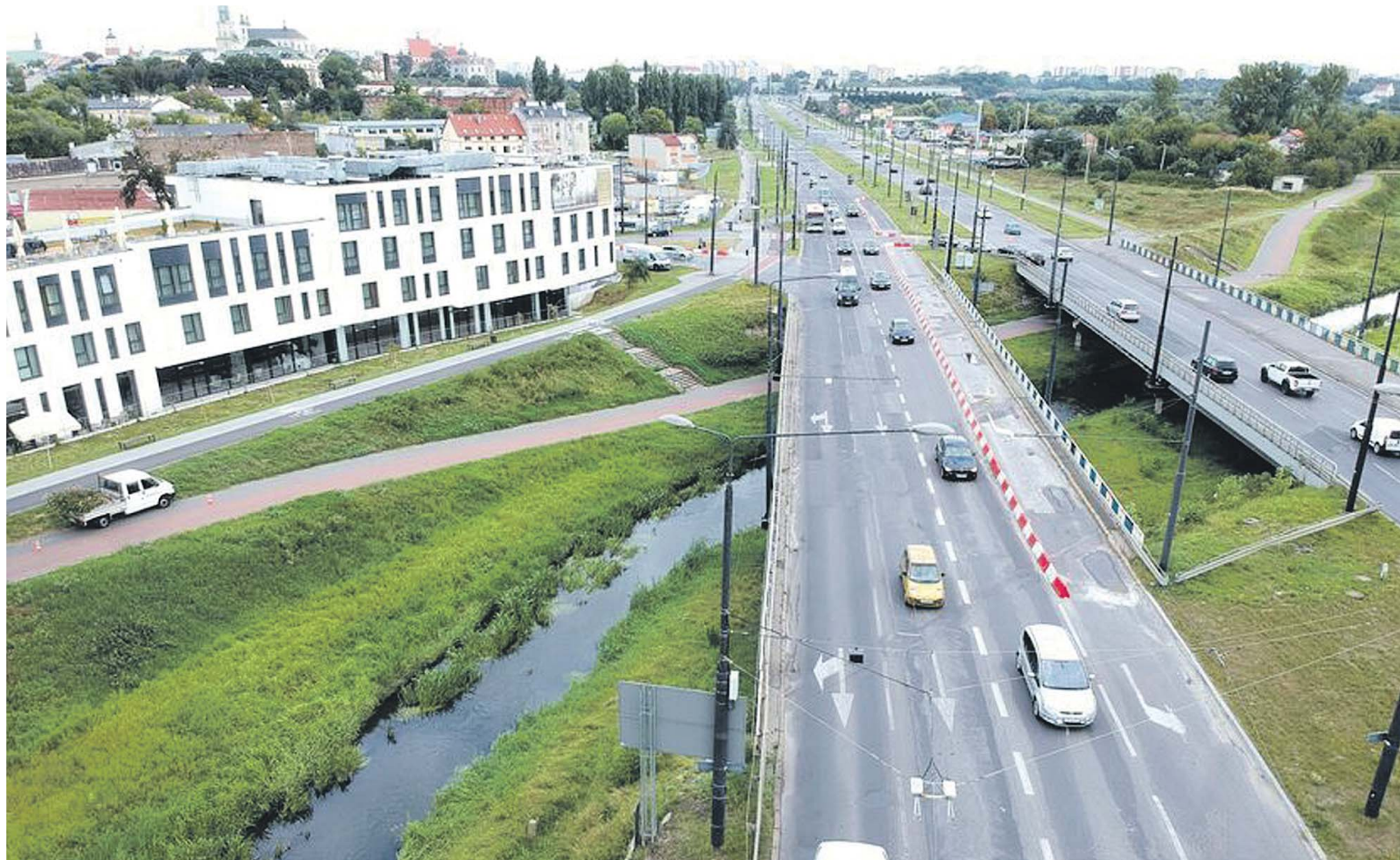
Stare mosty mają być rozebrane i zastąpione nowymi konstrukcjami
