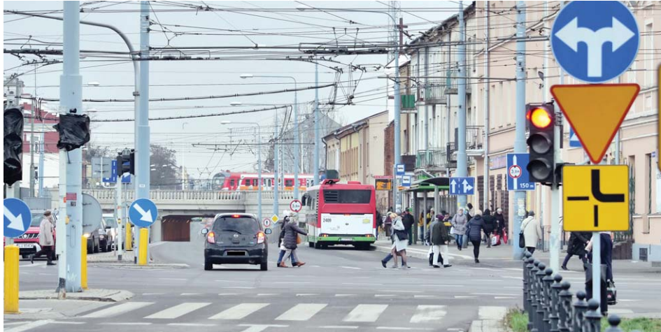
Wczoraj na ul. 1 Maja pojawili się robotnicy, którzy zdzierali z asfaltu żółte, tymczasowe oznakowanie. Ratusz zapowiada, że nie przywróci tu możliwości jazdy na wprost
