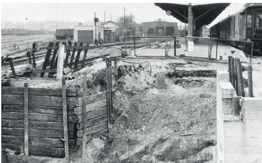
Dworzec PKP, już z nowymi peronami i przejściem podziemnym
