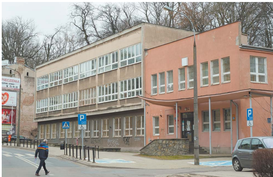
Stary biurowiec przy ul. Leszczyńskiego 20 ma być wyburzony. Większość urzędników już stąd przeniesiono do innych budynków, m.in. wynajmowanych przez miasto przy ul. Czechowskiej i Spokojnej
