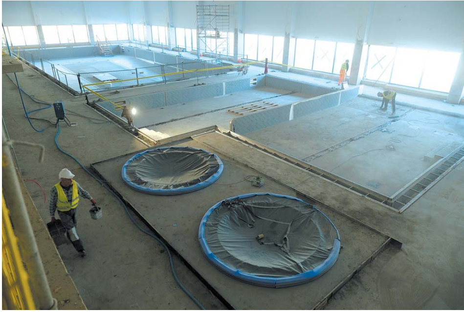
Park Avia to powstający przy ul. Fabrycznej kompleks sportowo-rekreacyjny, w skład którego wchodzi m.in. kryta pływalnia, baseny pod chmurką i boiska sportowe.
