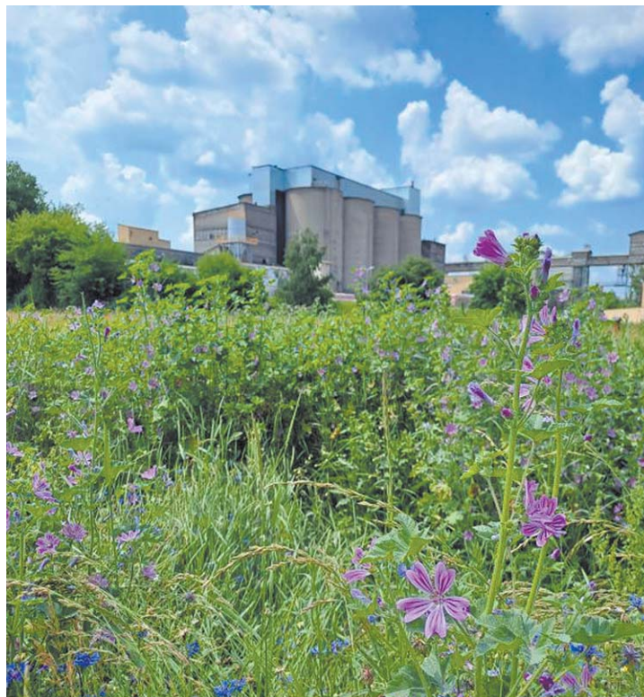
Na terenie Cementowni Chełm utworzono dwie wielkopowierzchniowe łąki kwietne o łącznej powierzchni około 8 tys. mkw
