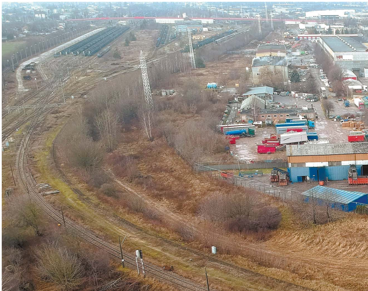
Hala miałaby powstać w dzielnicy Zadębie przy ul. Metalurgicznej
