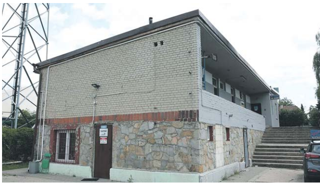
Istniejący budynek ma być wyremontowany, obok ma być dobudowana nowa część
