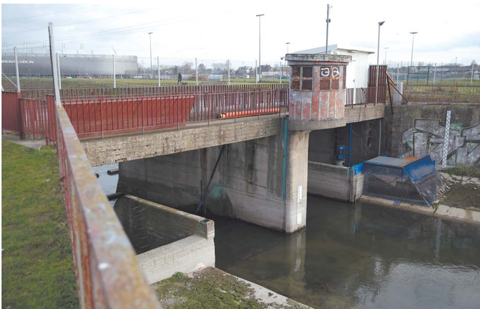
Spółka Hydrowatt stara się o nowe zezwolenie na działalność elektrowni wodnej na Bystrzycy
