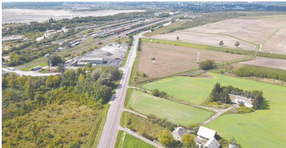
S12 – Okolice, w której zostanie wybudowany węzeł Chełm-Wschód
