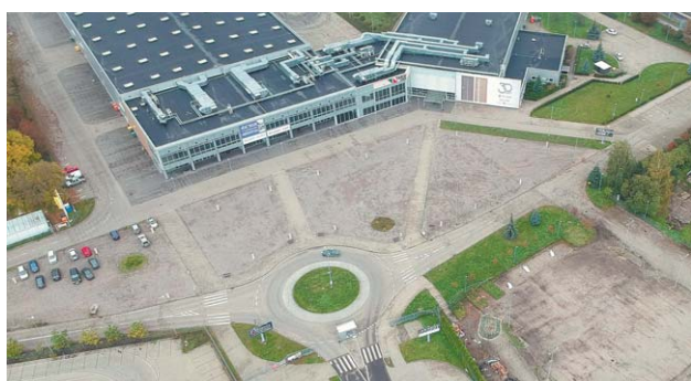
Nowe drogi koło Targów Lublin mają być gotowe za niespełna 10 miesięcy
