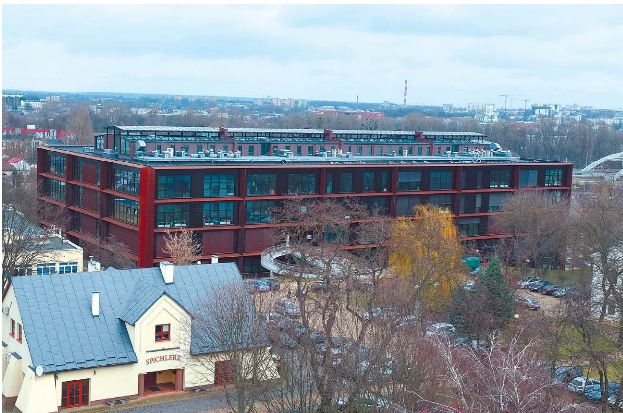
Nowoczesny sprzęt trafi do budynku Centrum Innowacji i Zaawansowanych Technologii Politechniki Lubelskiej
