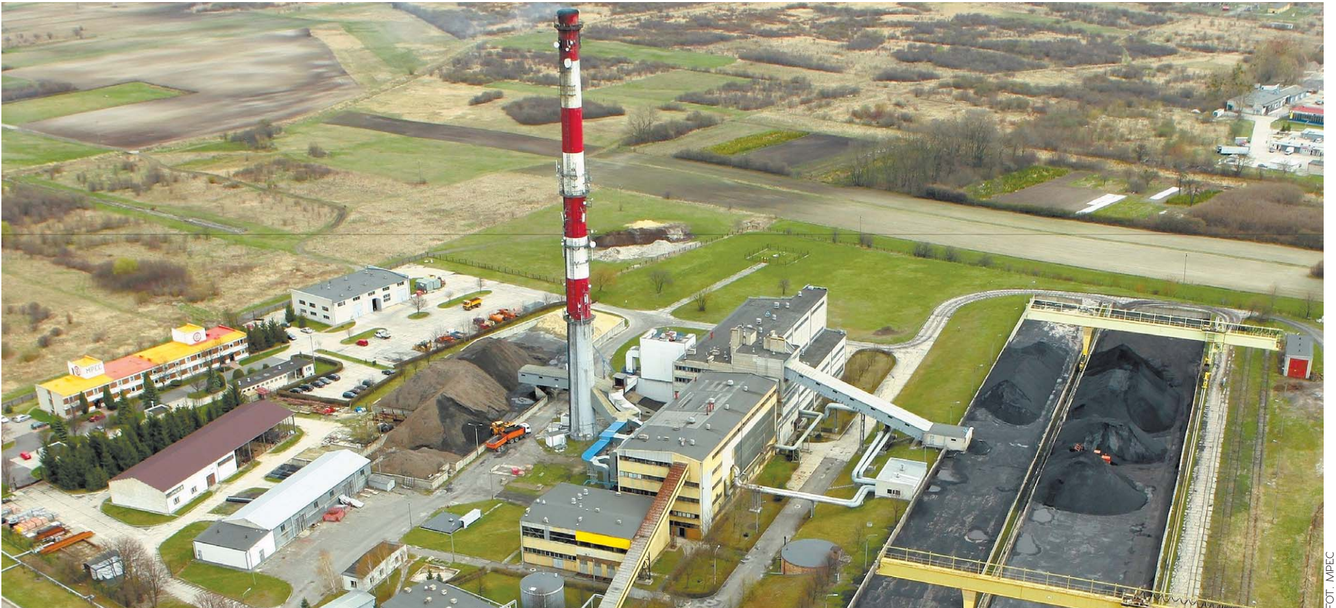
Miejskie Przedsiębiorstwo Energetyki Ciepłej w Chełmie ma się także stać elektrownią. Wszystko za sprawą dofinansowania z Narodowego Funduszu Ochrony Środowiska i Gospodarki Wodnej
