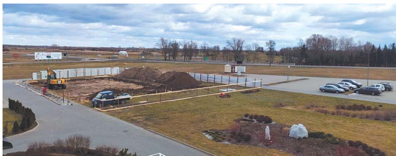
Budowa przychodni w Kobylanach
