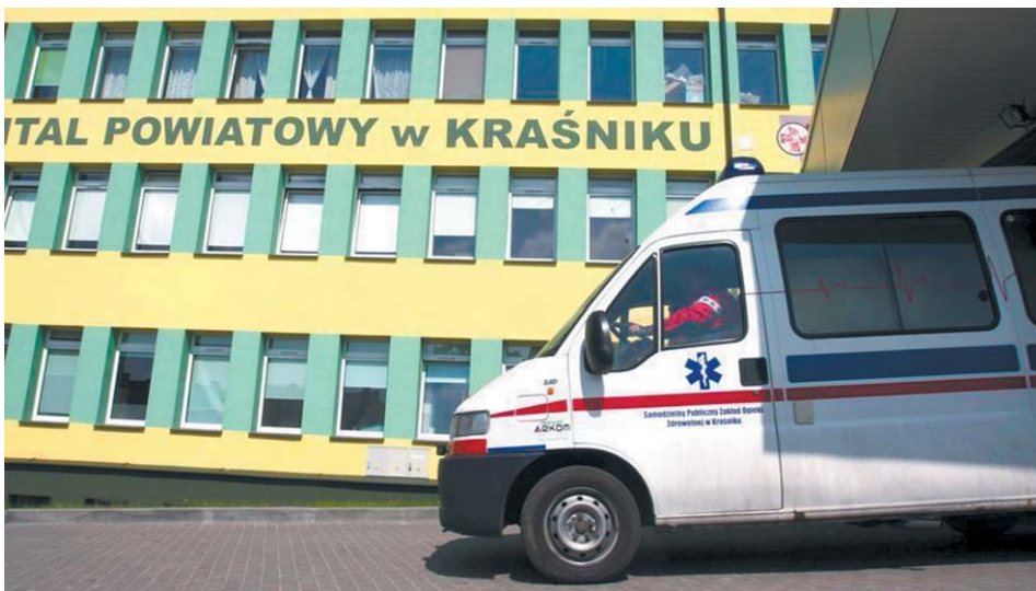
Do głównego budynku szpitala ma zostać dobudowane skrzydło
