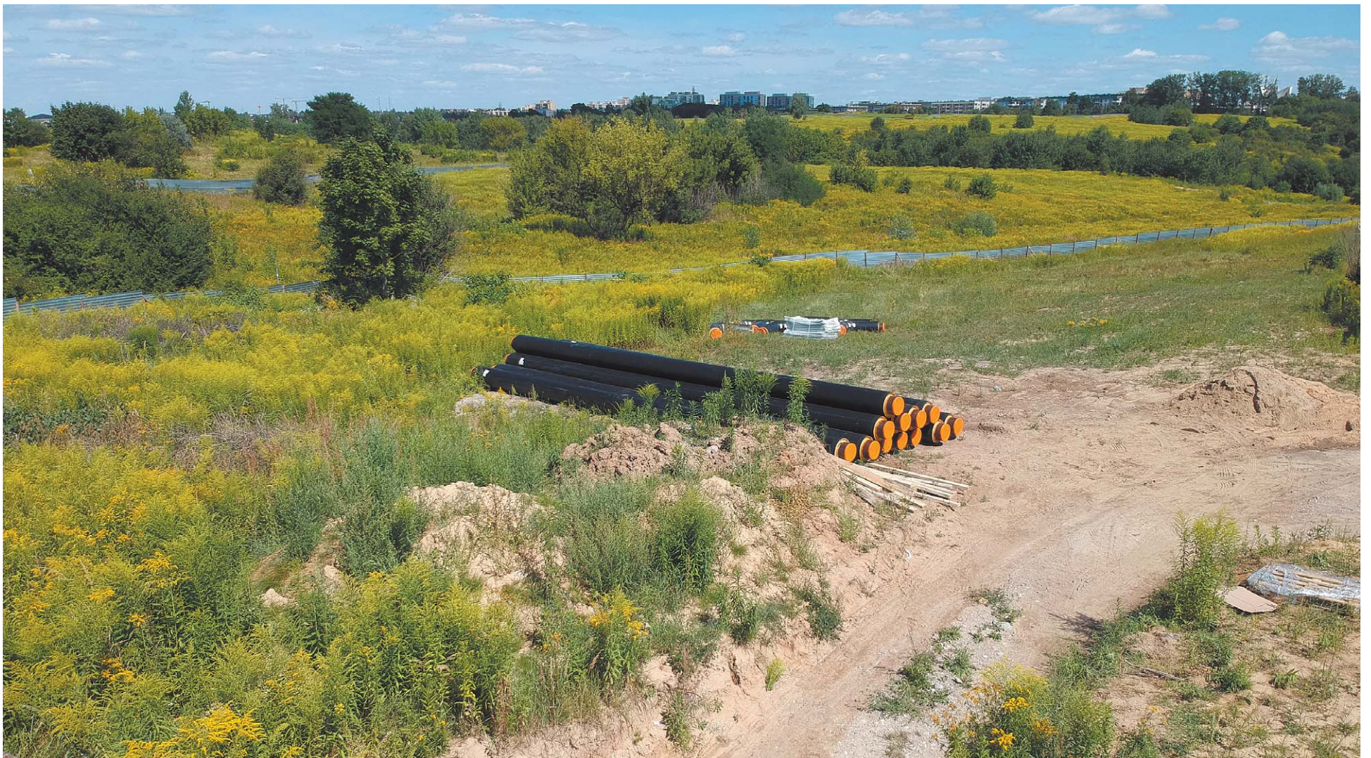
Wczoraj zwożono tu rury, które mają dostarczać ciepło osiedlom po drugiej stronie ul. Poligonowej
