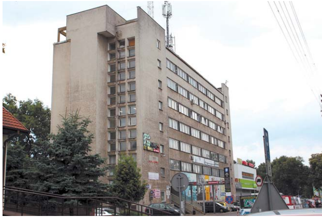
Po zaniedbanej elewacji nie ma już śladu
